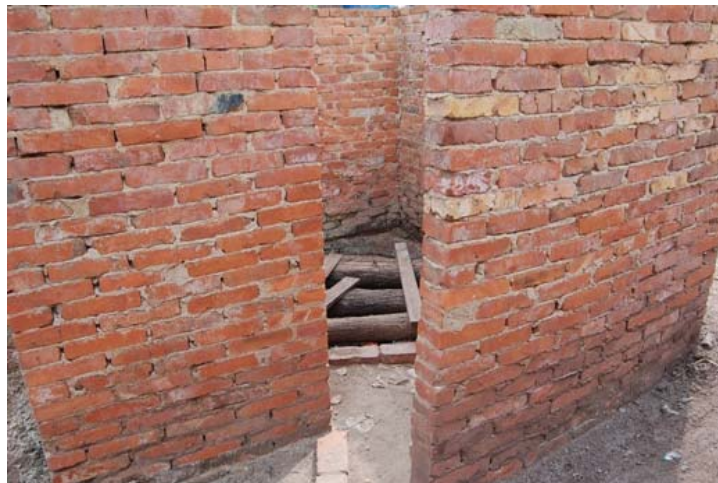
图 4.4 当地村子中厕所的一般构造
